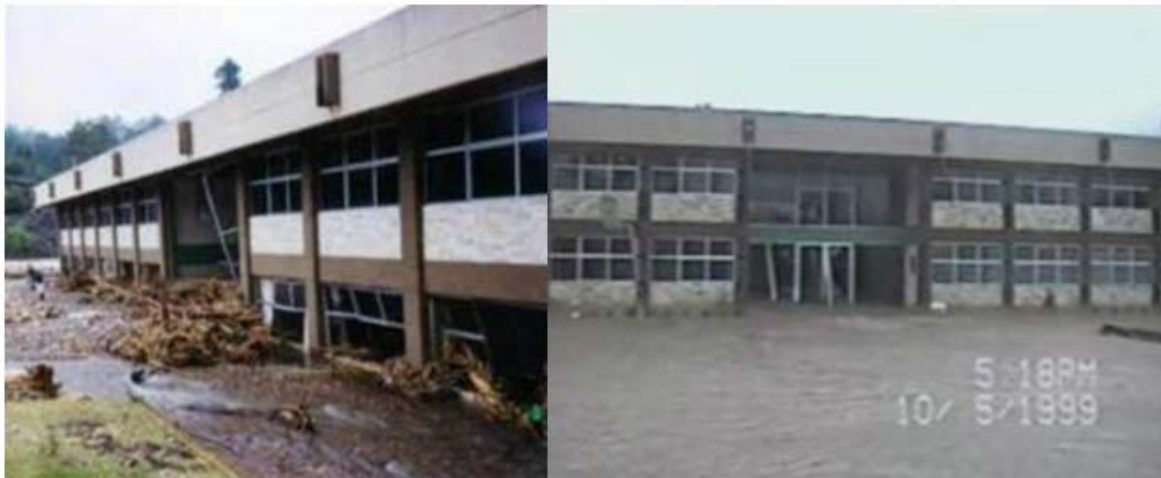
Figura 8. Instalaciones del ITST afectadas por las inundaciones de 1999
