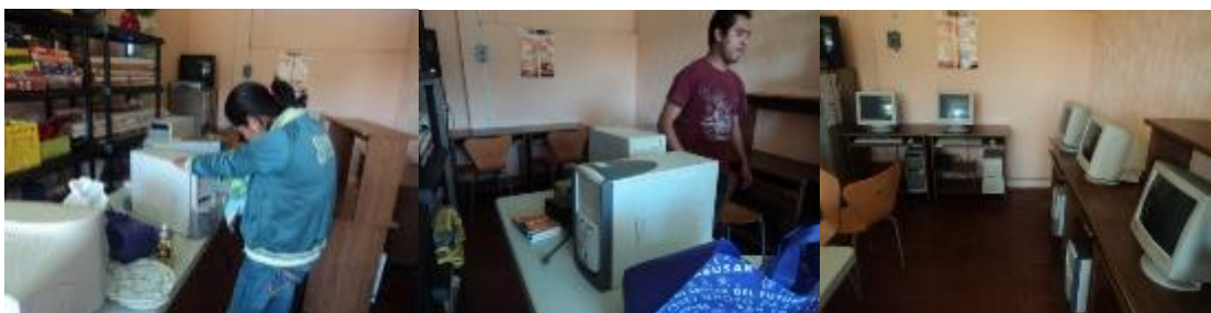
Figura 5. Instalación de equipo de cómputo en aula.
