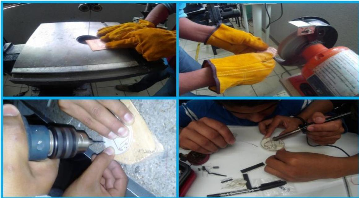
**Figura 7. Forma, perforación y estañado de las etapas**
